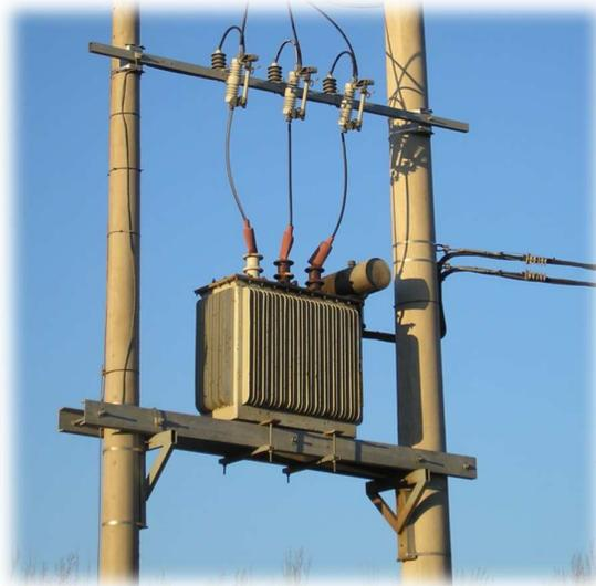
Se proveen con ambas abrazaderas con espigas, del diámetro que se solicite, con 2 largueros de perfiles UPN, 2 soporte de trafo de UPN, 2 triángulo soporte con sus abrazaderas de  $\frac{3}{4}$  en "U" y tillas.
